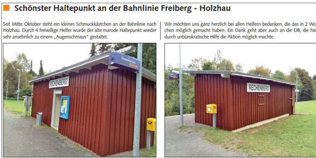
Abbildung 55: Ehrenamtsarbeit: Haltepunkt Rechenberg 45
