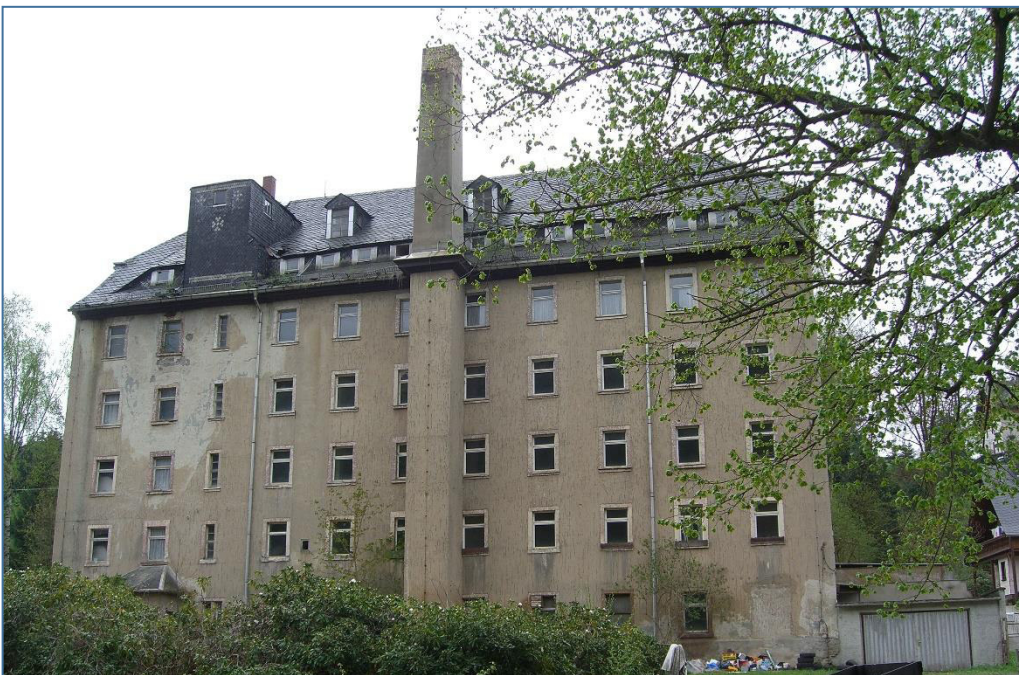
Abbildung 4: Abgerissenes ehemaliges Postferienheim Gemeinde Leubsdorf (Landkreis Mittelsachsen) unter Anerkennung des Eigenanteils als Ökokontomaßnahme (Foto: SLS GmbH 05/2010)
