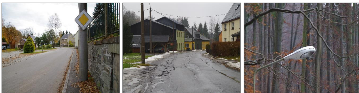
Abbildung 43: Dorfstraße Clausnitz, Muldentalsstraße Rechenberg, Beleuchtung Muldentalsstraße Holzhaus
